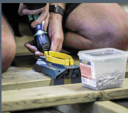
FAST DECK TOOL plasseres på terrassebordet, sentrert over bærebjelken. Skruene skrues deretter i de rake skrueshullene på verktøyet.
