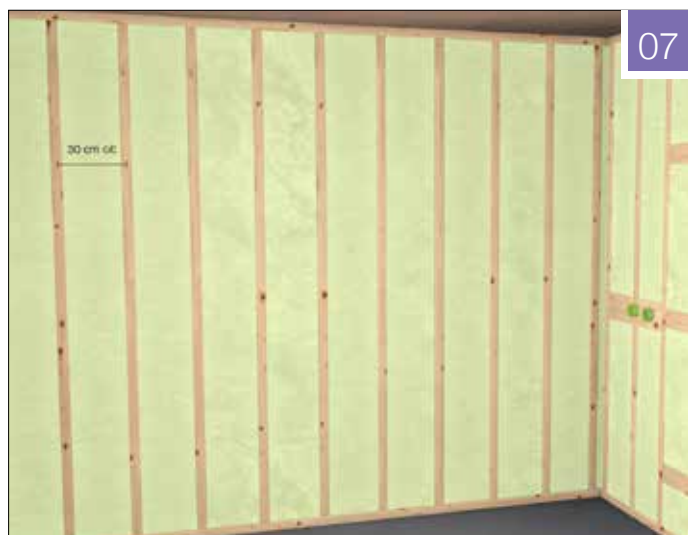
Fig. 07: På c/c 30cm stenderverk kan også 12mm Jackoboard Våtromsplate benyttes.
