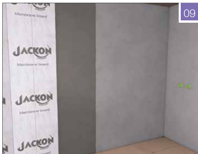
Fig. 09: Både Jackoboard Våtromsplate og Jackon Membrane Board kan benyttes ved montering på mur eller betongvegg. Hvilken plate som brukes avhenger av om vegg er mot kaldt eller varmt rom.
