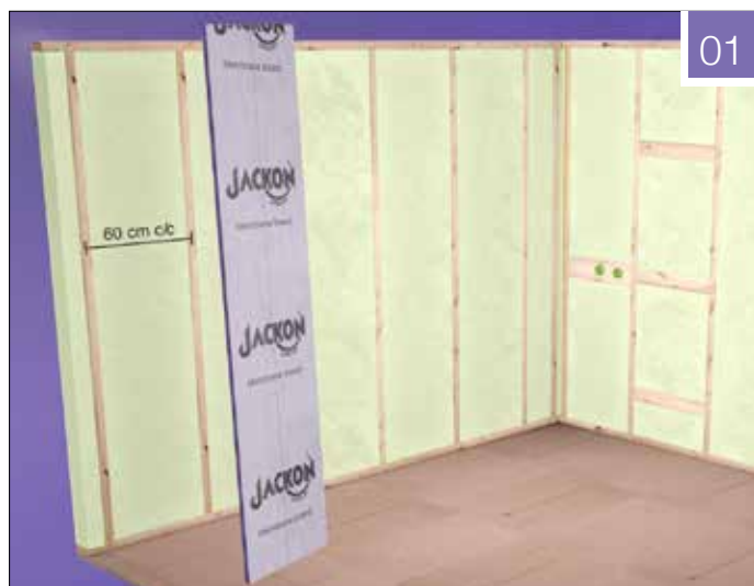
Fig. 01: 20mm plater monteres på c/c 60cm stenderverk. Sørg for at platene ikke monteres i spenn og at de har en liten klaring mot tak og gulv.
