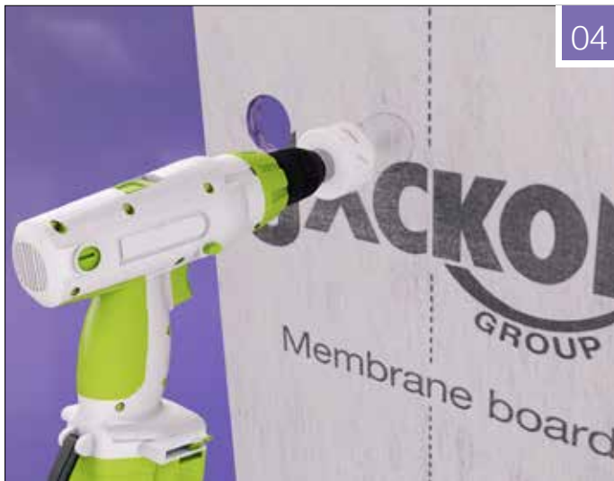
Fig. 04: Press platene mot rørstussene slik at du får et avtrykk på baksiden av platene. Skjær deretter ut hull til rørstussene med hullsag for drill eller tapetkniv.
