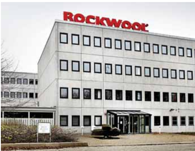
Administrasjonsbygget til ROCKWOOL A/S før rehabiliteringen.
