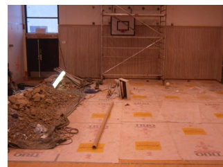
Beskyttelse av ny parkett i gym-sal under rehabilitering
