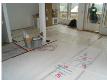
Beskyttelse av ny parkett under bygging av rekkehus i Lommedalen
