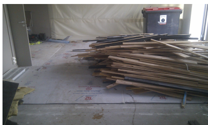
Beskyttelse av gulv under rehabilitering
