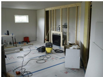
Beskyttelse av gulv ved installasjon av ny peis
