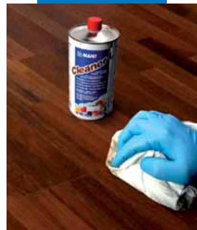
Rengjøring av lagt parkett med Cleaner L
